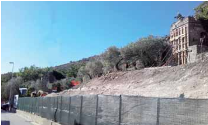
Località Maielli; martello, pala meccanica ed altro per demolire la roccia per la realizzazione del parcheggio
