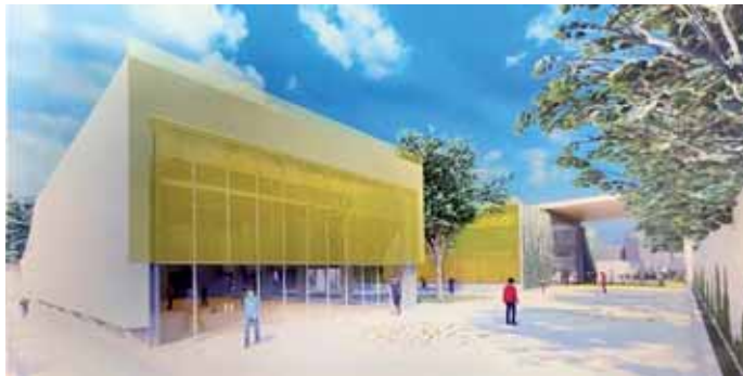
Frazione San Marco in viale dell'agricoltura : realizzazione della rete fognaria, marciapiedi e riqualificazione stradale
